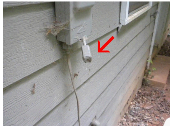
Remove pad lock & install conduit
